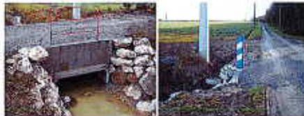
Compactage de la diorite, joints de liaison des blocs en béton, fixation des ballises
