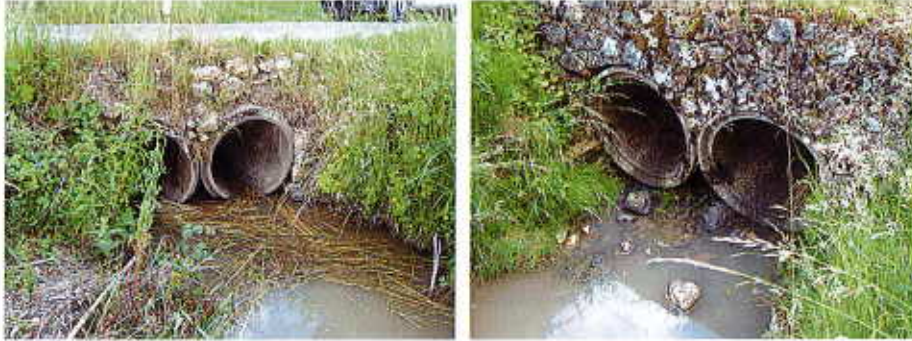
Vues de l'amont et de l'aval de l'ouvrage avant travaux
