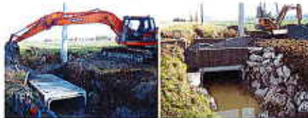
Habillage de la périphérie des cadres avec des enrochements et muret de stabilisation des matériaux
