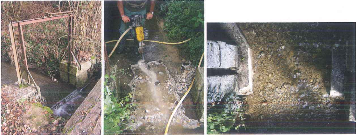
Seuil de la Mondinerie (Beaumont la Ronce)
