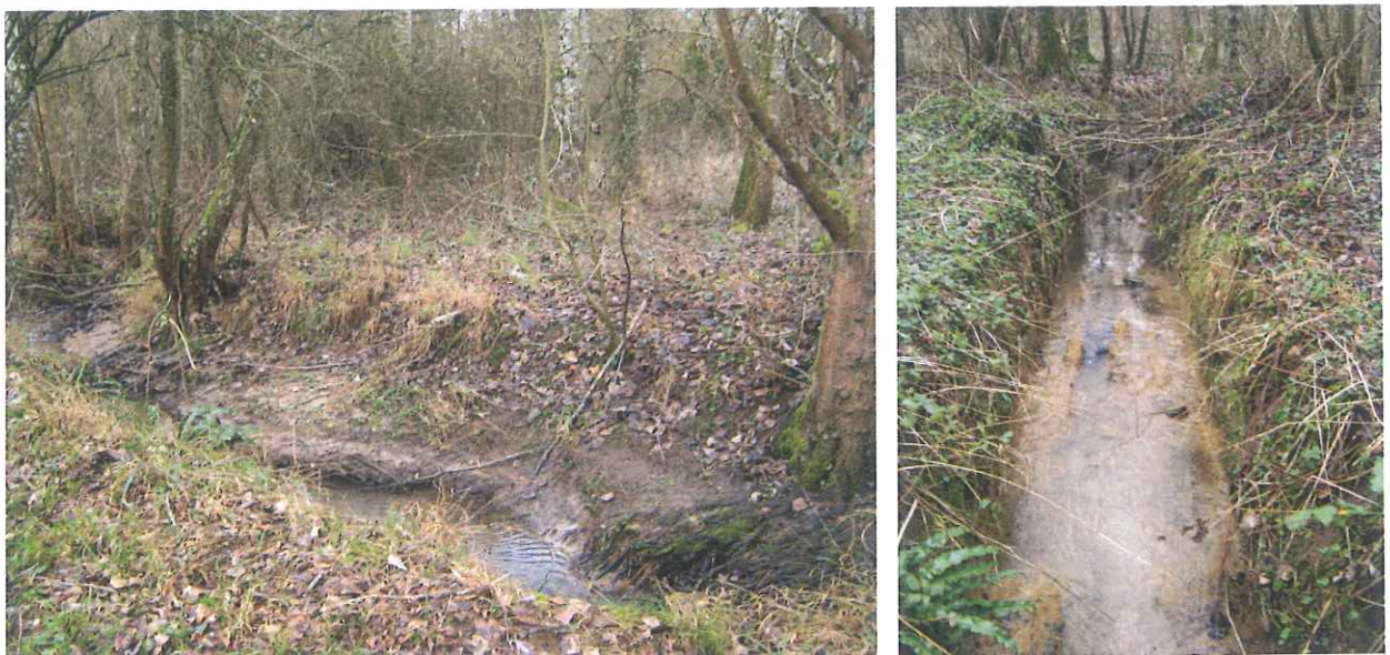
Station du secteur de la Touche (3) avant travaux de restauration
