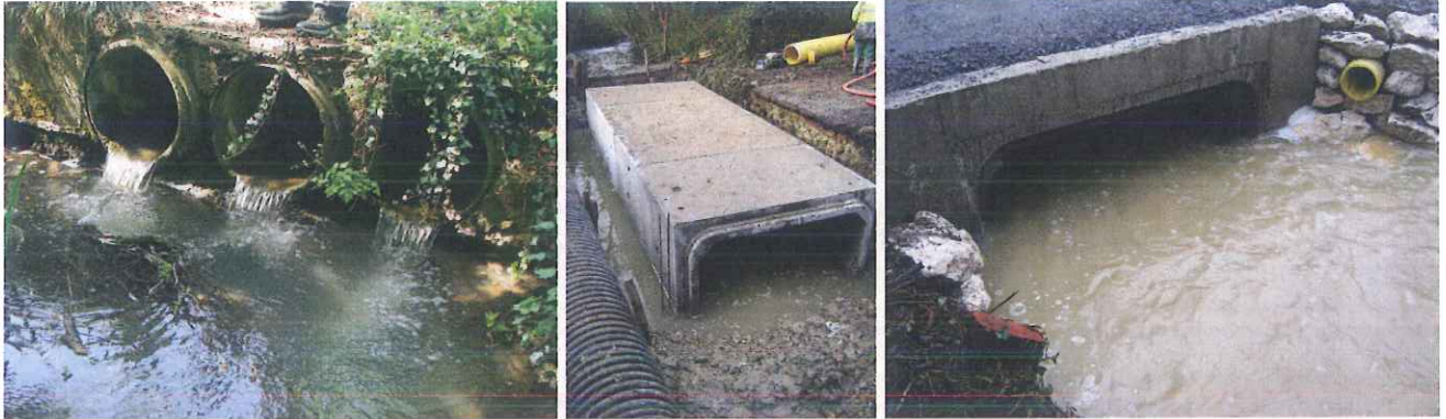
Ouvrage de franchissement du Moulin de Berton (Nouzilly)
