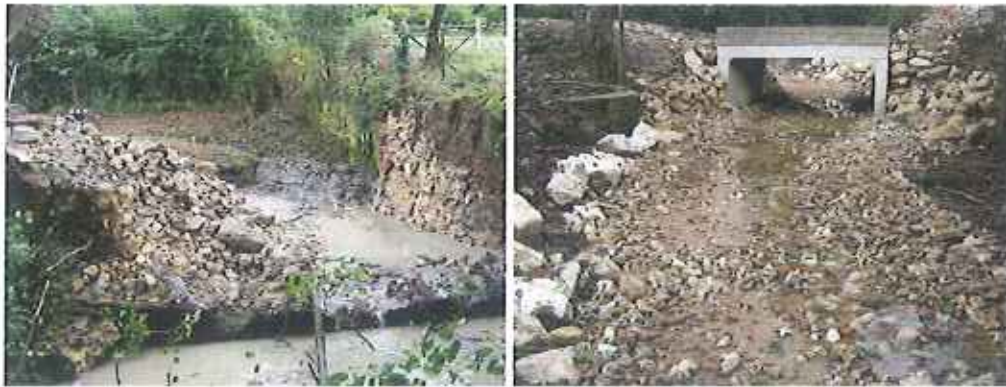
Démolition de l'ancien vannage et aménagement d'un pont cadre
