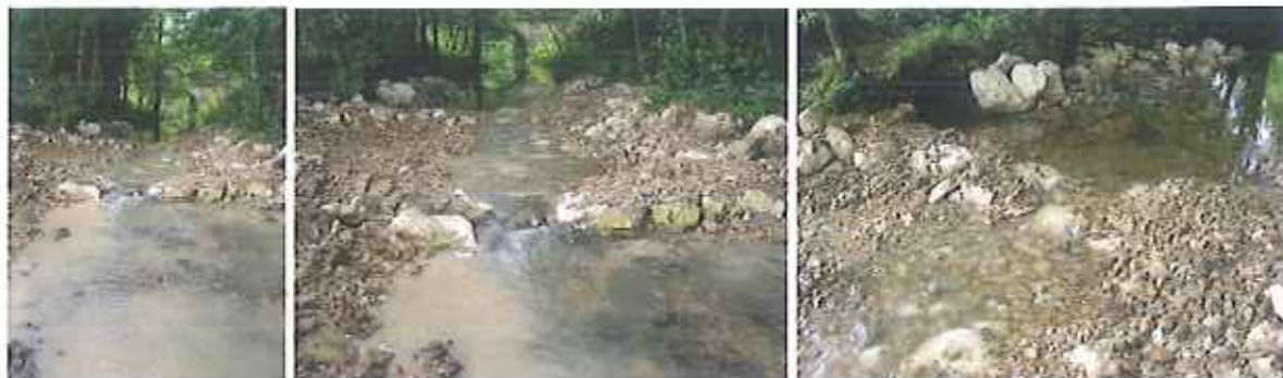
Aménagement du seuil de répartition amont
