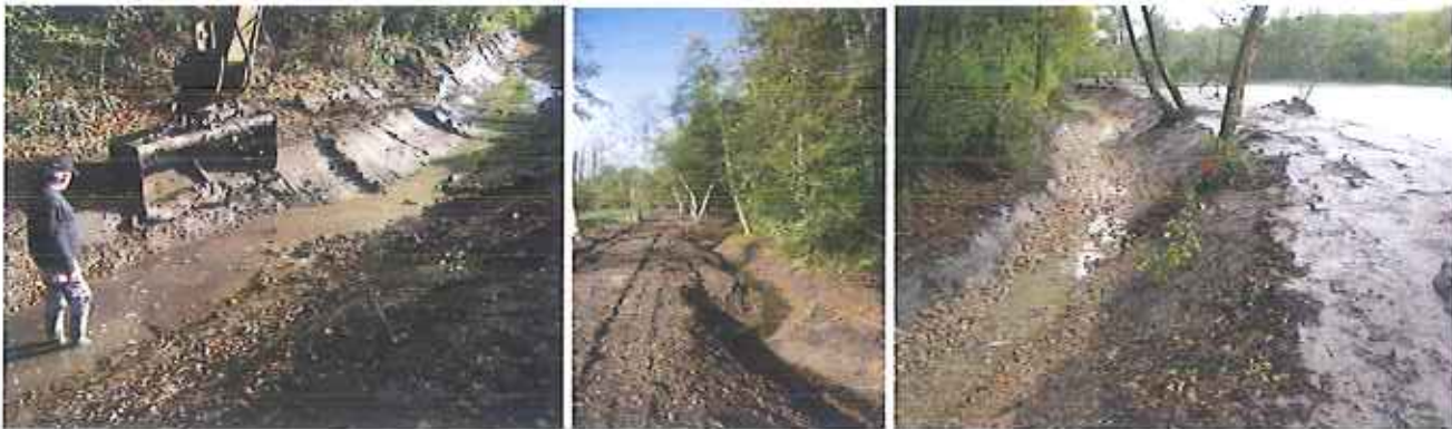
Reprofilage du lit avant recharge
