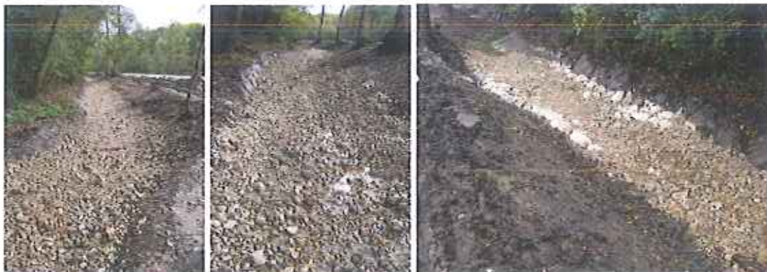
Création d'un matelas alluvial et aménagement d'un seuil ennoyé
