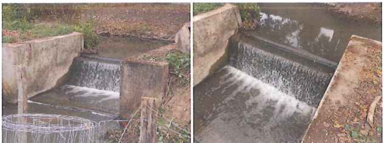
Déversoir des Ponceaux avant aménagement
