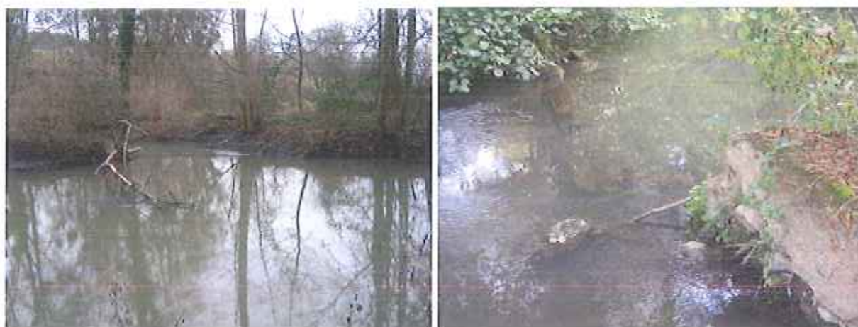
Vues de l'ouvrage de répartition
