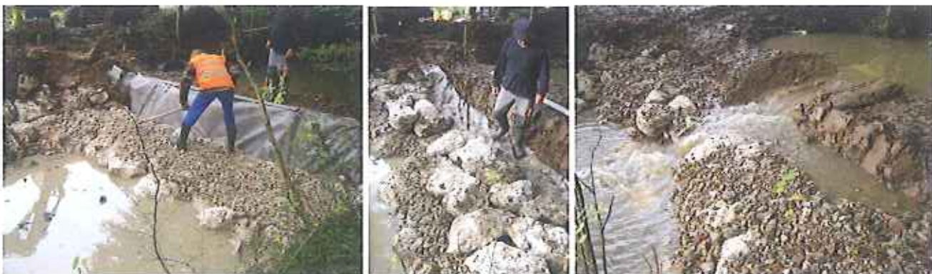
Aménagement d'un seuil franchissable par conception pour l'alimentation du plan d'eau
