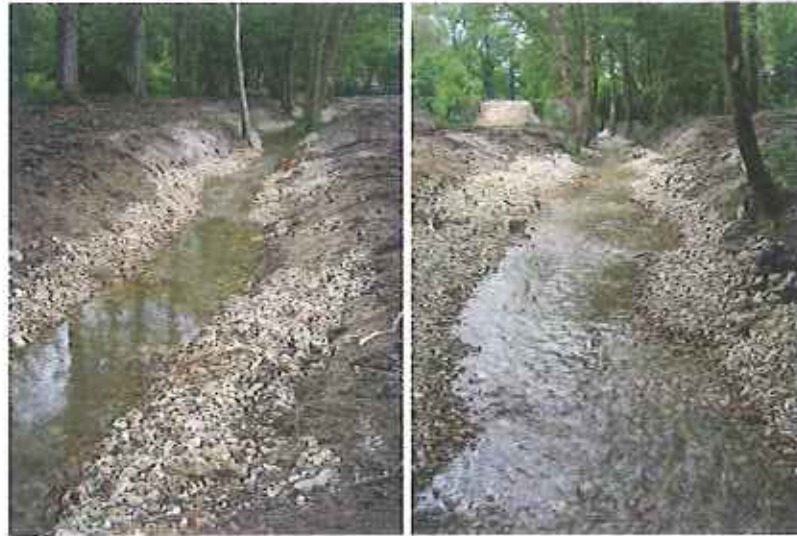
Vues amont et aval du cours restauré de la Choisille de Chanceaux
