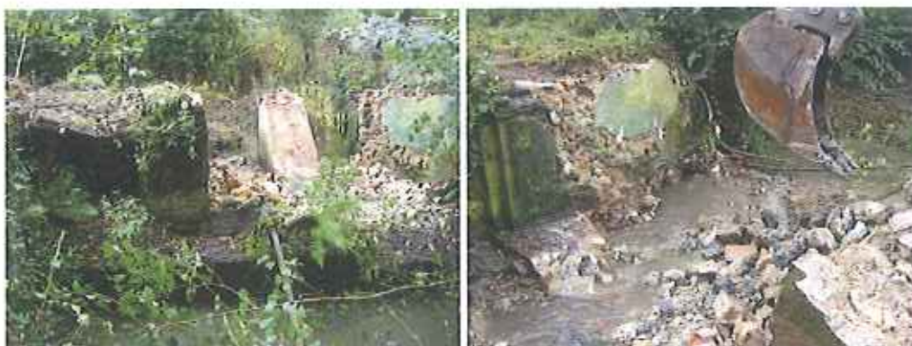
Démantèlement de l'ancien vannage servant de passerelle
